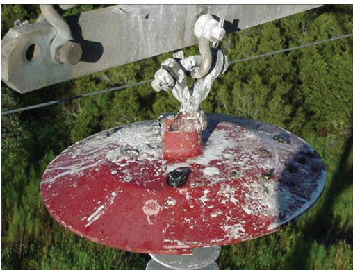
Защитный зонтик RRGS для полимерного изолятора
