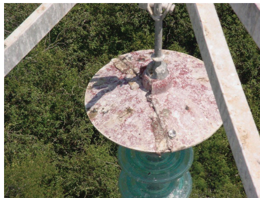
Защитный зонтик RRGS для стеклянного изолятора
