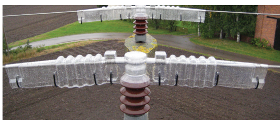
BCIC-1217-TR: Установка на опорные изоляторы
