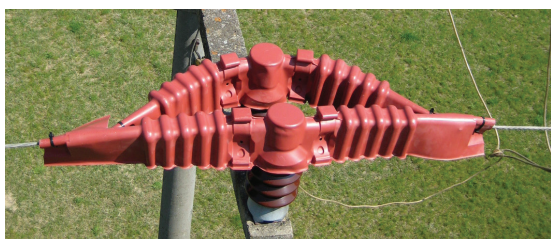
BCIC-1215: Установка на сдвоенные изоляторы
