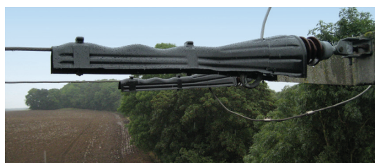
BCIC-TEN-01: Установка на натяжной изолятор
